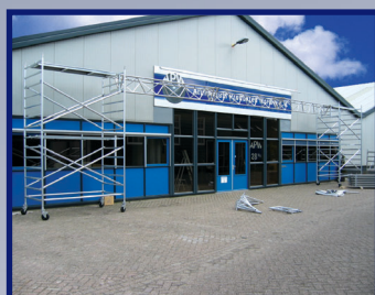
De truss tussen de steigers plaatsen
